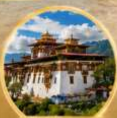
พุนาคาซอง
