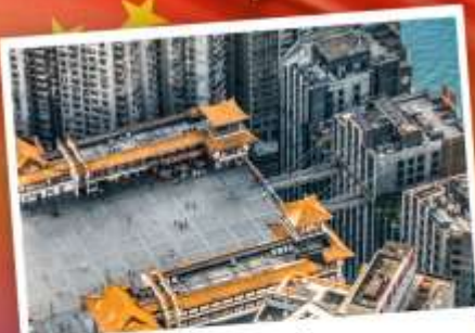
อาคารยุคใหม่
