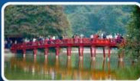
สะพานแสงอาทิตย์
