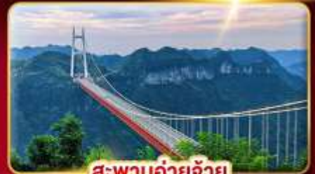
สะพานอ้ายจ้าย
